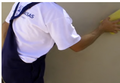
Acabamento areado com REABILITA Cal Acabamento
