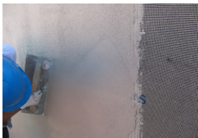
Execução da camada de regularização
