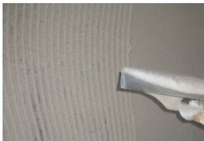
Primeira camada sobre o isolamento
